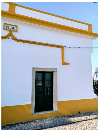
Foto 1 - Porta exterior (visto por fora)
